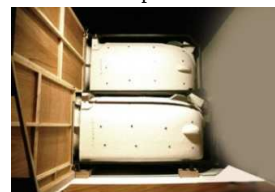
Gambar II.31 Hasil Pemasangan Unit Kapsul
